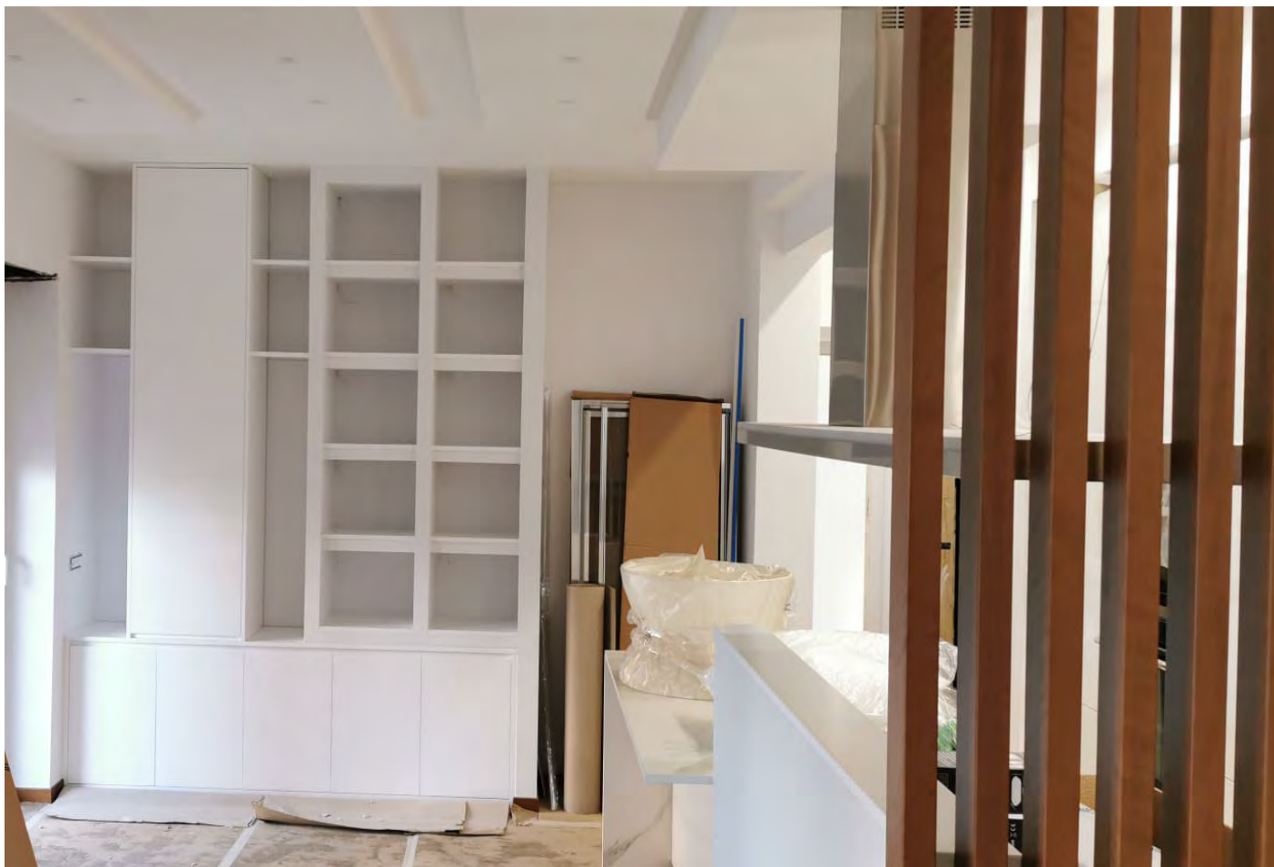
2021: Lavori di manutenzione straordinaria appartamento via Laurentina, Roma.
